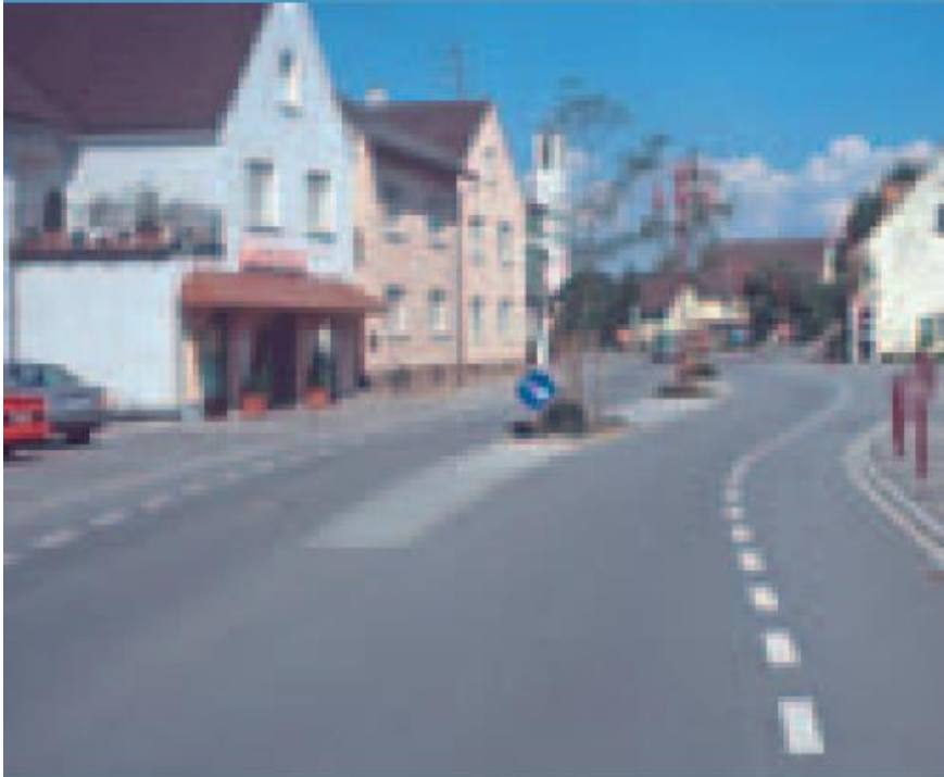
Schutzstreifen in einer ländlichen Ortsdurchfahrt
